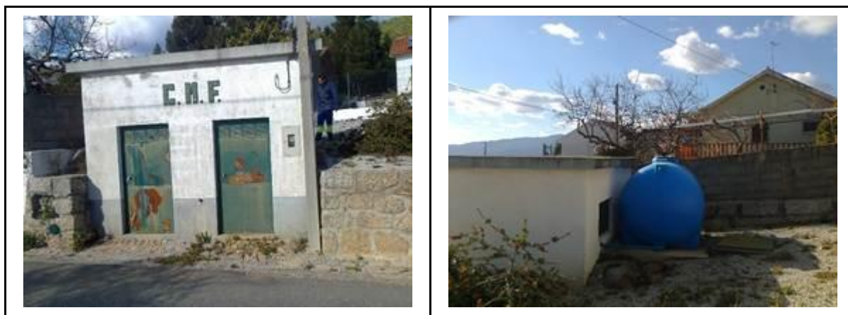
Figure 4. Monte Leal Installation – Fundão.
