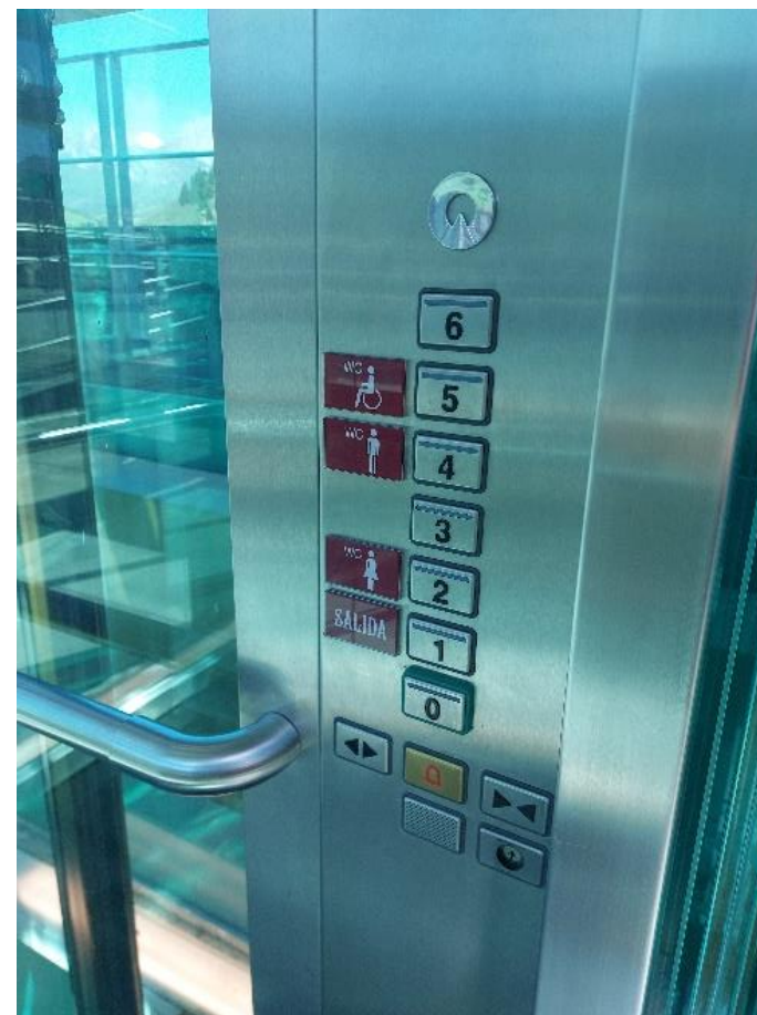
Señalización clara y accesible que indica la ubicación de los baños
