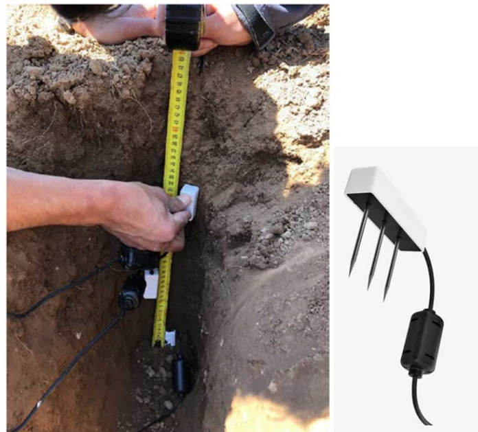
Ilustración 16: Instalación de sondas de humedad a distintas profundidades
