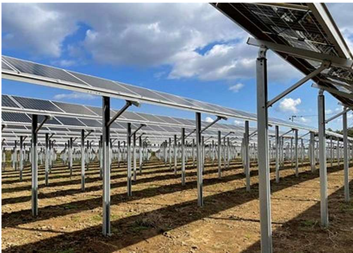
Figure 2: Structure fixe surélevée
