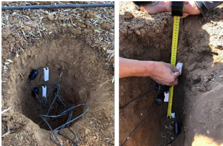
Figura 5: Instalación de sensores modulares.
